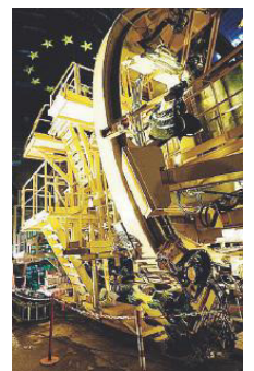
TAV Parte del cantiere
