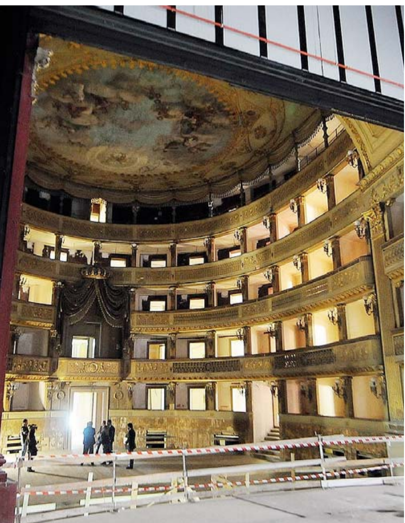
GLI INTERNI Il cantiere nel teatro di corso Vittorio Emanuele (foto Luca Turi)
